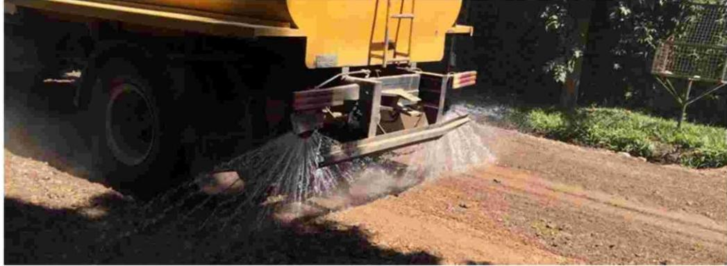
La aplicación del SOIL PLUS diluido para la estabilización se realiza por medio de un camión tanque para regado preferiblemente por gravedad.
