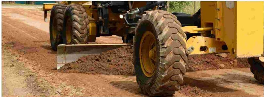
Después de la aplicación del estabilizante, la superficie debe ser perfilada a un galibo previamente determinado.
