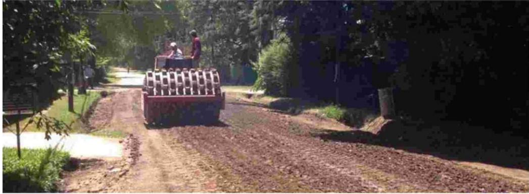
Tanto la compactación como el mezclado, son pasos claves en las técnicas de estabilización, la capacidad de carga final se incrementara notablemente con una buena compactación. Esto se consigue con varias pasadas sobre la superficie estabilizada de un rodillo compactador "pata de cabra" o neumático hasta obtener valores previstos.
