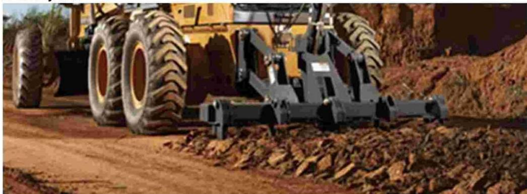
El escarificado del suelo se realiza en la profundidad requerida según el espesor de la capa de suelo que se desea estabilizar. Esta profundidad ronda entre 15 y 30 cm en los casos de estabilización de calles de tierra.
